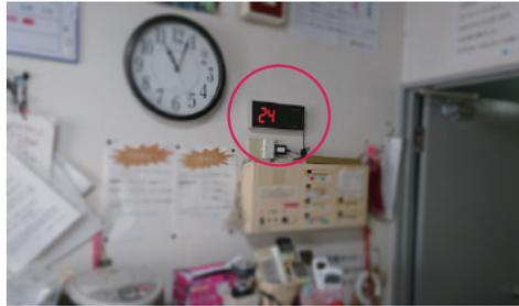
一枠受信機の下にあるのは、既存のナースコール。今回こちらが故障したため、ソネット君に入替していただきました。他にも手元で呼び出しがわかる携帯受信機も併用中。
